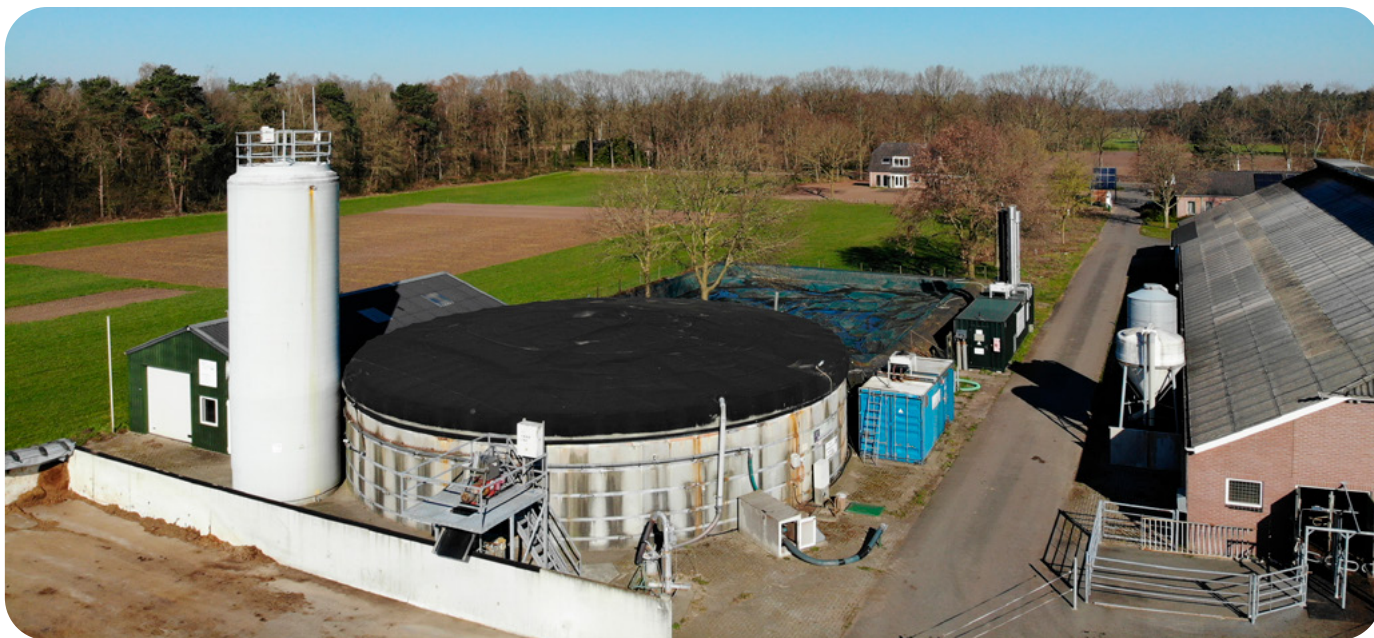
Biogasinstallatie op De Marke (2003 – 2019).
