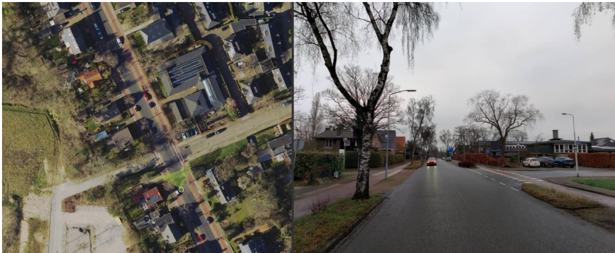
Figuur B1.6: De huidige vormgeving van het kruispunt Diedenweg - Verbindingsweg (bron: Cyclomedia).
