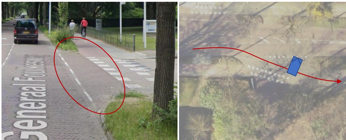
Figuur B1.4: Links, de beperkte opstelruimte voor autoverkeer tussen de rijbaan en de fietsoversteek. Rechts, het mogelijk blokkeren van de toegang tot de parallelweg.
