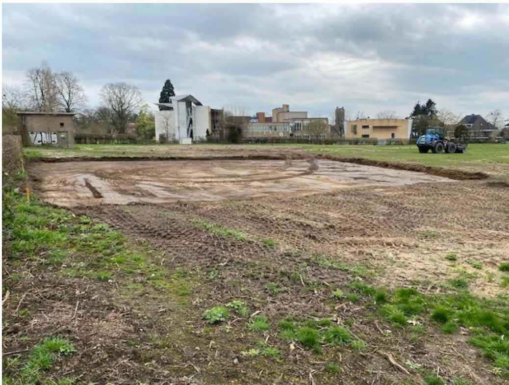
Situring huidig maaiveld na afvoer klasse industrie grond d.d. 29 maart 2023
